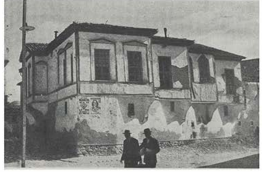
Geleneksel Konya evlerinde çıkma örnekleri. Sırasıyla Hayatlı iki katlı evin birinci katında odanın gönye/üçgen çıkma ile sokağa uzanımı (Berk, 1951), Destekli çıkma örneği (Berk 1951), Her mekan için gerçekleştirilen gönye/üçgen çıkma örneği (Berk, 1951).
