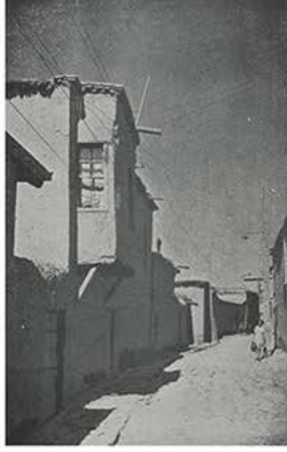
Geleneksel Konya evlerinde çıkma örnekleri. Sırasıyla Hayatlı iki katlı evin birinci katında odanın gönye/üçgen çıkma ile sokağa uzanımı (Berk, 1951), Destekli çıkma örneği (Berk 1951), Her mekan için gerçekleştirilen gönye/üçgen çıkma örneği (Berk, 1951).
