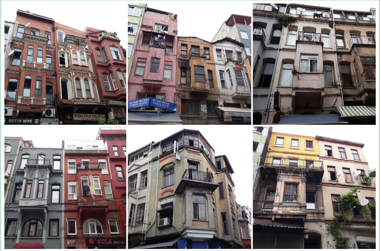
Şekil 11. Fatih'te, sonradan çıkarılan katlarla orijinallikleri bozulmuş sivil mimar örnekleri. Yapıların bulunduğu semt, Gedikpaşa (Kaynak: Yazarın Kişisel Arşivi, 2019).
