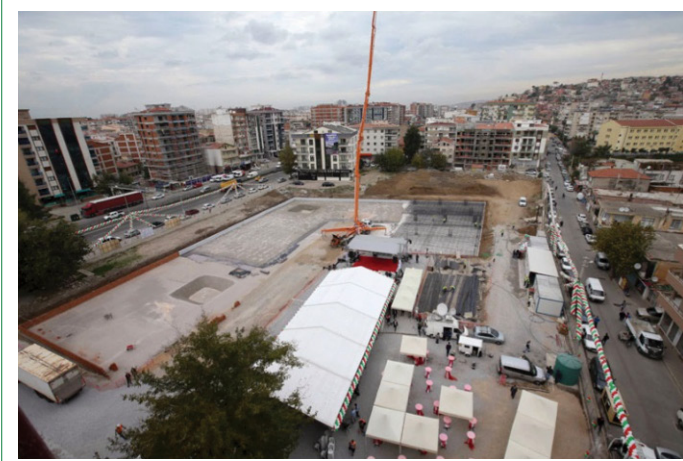
Şekil 6. Ege Üniversitesi Karşıyaka Suat Cemile Balcıoğlu Yerleşkesi inşaatı (URL-11).
