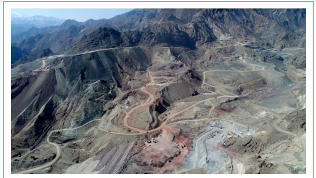
Şekil 18. Yeni yerleşim yerinde yapılan altyapı çalışmaları. Kaynak: DSİ.
