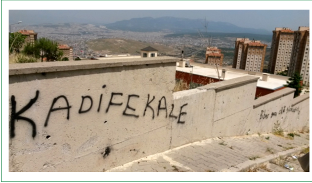
Şekil 11. “Kale” ruhunun Uzundere’de var olma çabası, Uzundere yeni yerleşim alanındaki ilköğretim okulunun ve konut bloklarının istinat duvarlarındaki “Kadifekale” yazılarına sıkışıp kalmış (Kaynak: I. Yazar kişisel arşiv, 2015).
