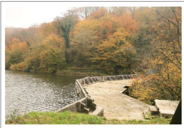
Figure 5. Ayvat Dam (Eyüp Sultan Belediyesi, n.d.).
