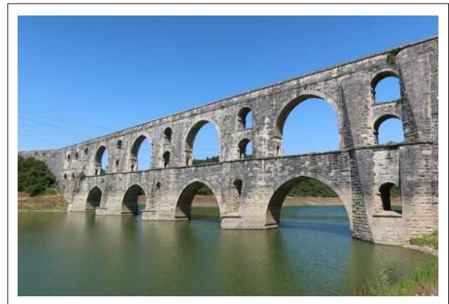
Figure 4. Mağlova Aqueduct (Kültür Envanteri, n.d.)
